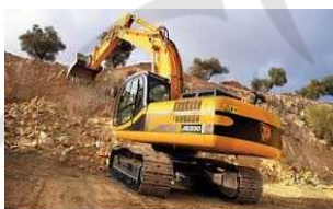
Movimiento de tierra
